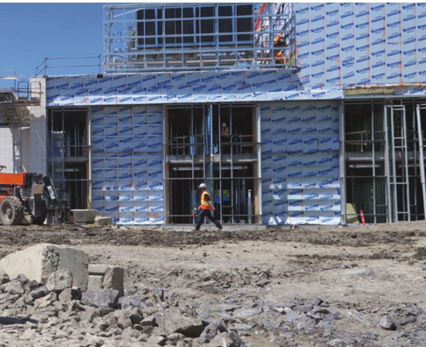
Photo : Visite de chantier d'une maison des aînés, juin 2020.
